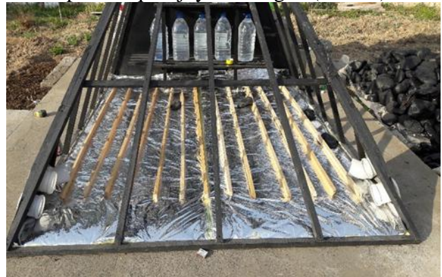
1-rasm. Kollektorning tag qismini izolyatsiyalash.
