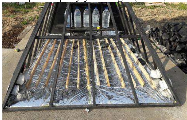
1-rasm. Kollektorning tag qismini izolyatsiyalash.
